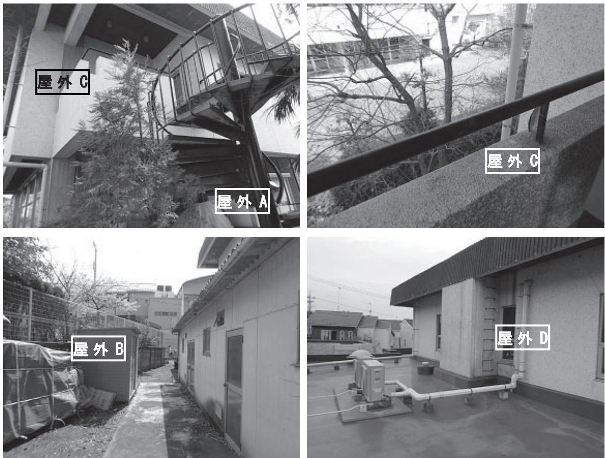
写真 1 トラップ設置地点現地写真
